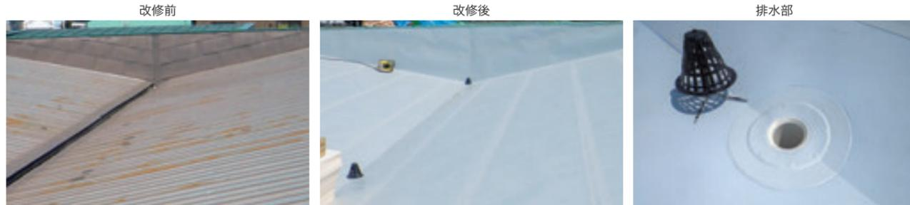
無落雪屋根に多いですがもれの原因である樋部分を塞ぎ、室内への漏水を防止します。
