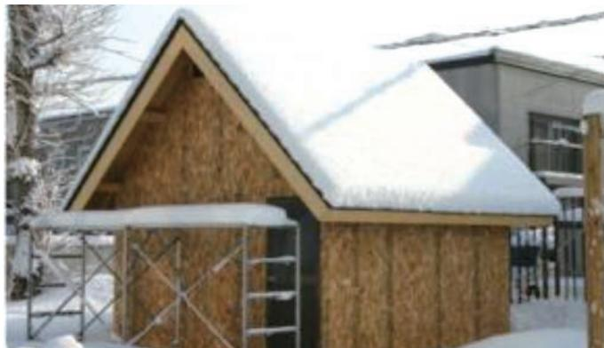
15mm立ち上げたリブによる雪止め部で雪の滑落を抑止させる工法です。融雪水の排水は妻側のケラバ屋根面で自然流下させ軒先から地上へ自然排水します。
