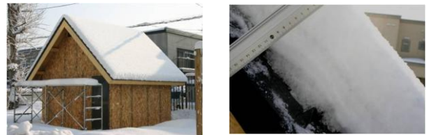
写真1 屋根上最大積雪26cmの屋根雪状態
